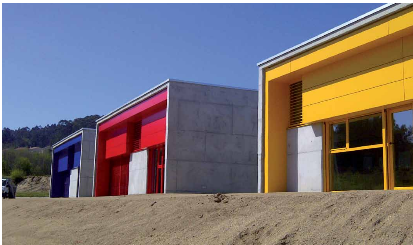
Vista general de la guardería municipal de Sanxenxo, en ella se utiliza biomasa como combustible para la calefacción.
