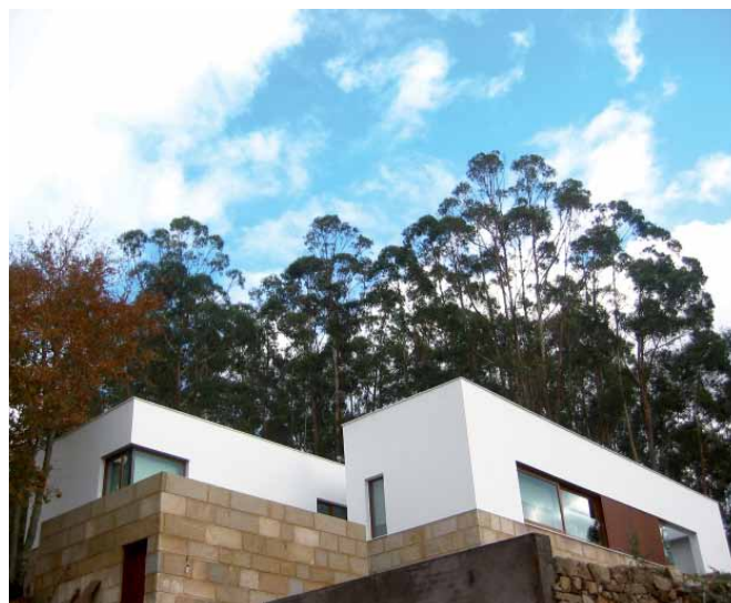
Vivienda en Pontecaldelas con calefacción de biomasa.
