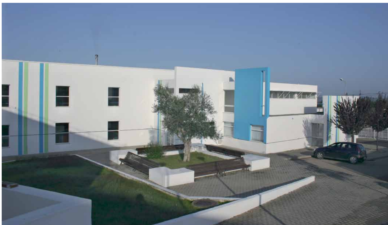
Vista del exterior de la piscina pública de Alcácer do Sal.
