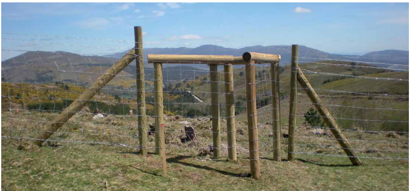
Cierre perimetral de la parcela de Parada de Achas (A Cañiza).
