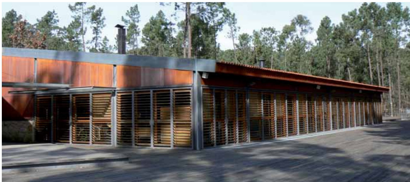
Edifício com sistema de aquecimento a biomassa florestal
