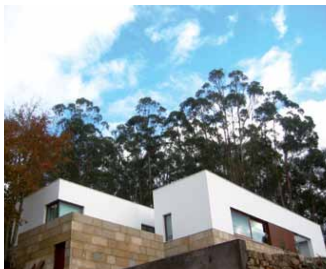
Habitação em Pontecaldelas com aquecimento a biomassa.
